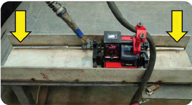
Welding edge to edge
