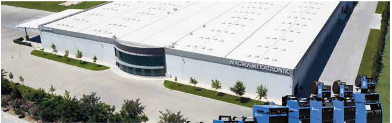
Welding Machines and Automation Factory Organize Sanayi Bölgesi 5. Kısım - Manisa / TURKEY
